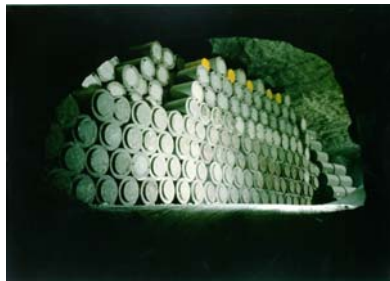
Abb. 3: Einlagerung von schwachradioaktiven Abfällen in verlorenen Betonabschirmungen
