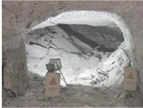
Abb. 6: Kammer mit schwachradioaktiven Abfällen und Salzversatz, Stapeltechnik
