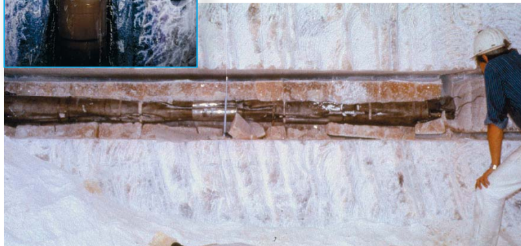
Temperaturversuch 5 - Nach Versuchsende freigelegter Erhitzer.
